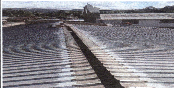
FOTOGRAFIA 2: se observa un 25% de avance del remozamiento del techo del modulo 3
