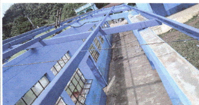
FOTOGRAFIA 1: se observa un 75 % avance del ramozamiento del techo de mdulo 1
